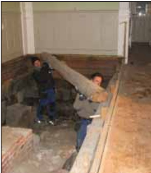
Fra arbeidet med å senke gulvene i sideskipene på kirken.
