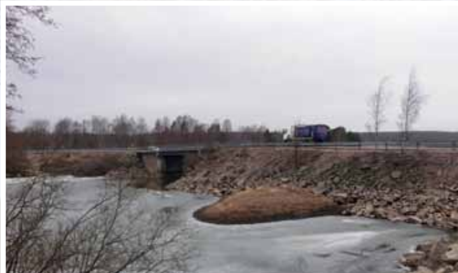
Nipebrua fra 1966 ligger nord for 1915-utgaven, og ble bygd for å tåle tretten tonns akseltrykk. (Foto: Øistein Bøe).
