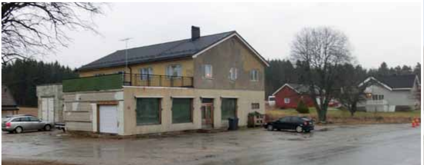
Bygget i Sikkelandtsveien ble i 2011 kjøpt av brødrene Espen og Stian Pedersen. De har pusset opp og leier ut de to leilighetene i andre etasje. Også verkstedet er pusset opp, og benyttes som hobbyverksted. Foto: Øistein Bøe.
