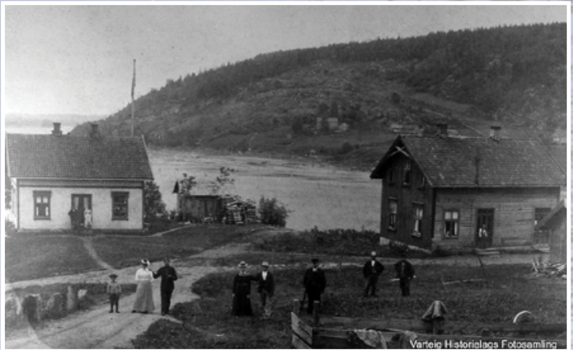
Dette bildet fra Tangen er tatt omkring forrige århundreskifte. Huset til venstre tilhørte Simen Syversen, og til høyre ser vi huset hvor Johan Andersen drev landhandel. Vi ser i bakgrunnen over elva til Suterens. Bildets eier: Varteig Historielags Fotosamling.
