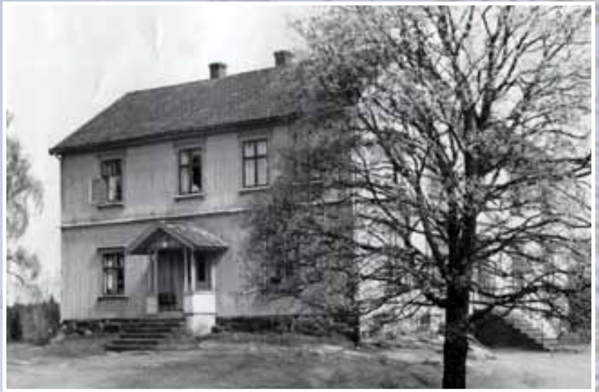
Kokkimskolen fotografert tidlig på 1950-tallet. Da hadde det vært skole her siden 1893. Foreningen Samhold overtok eiendommen i 1959. (Foto: Thor Fjeld.)
