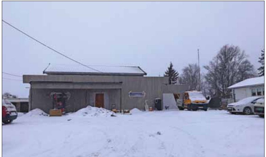
Arild Bøe Nå foregår det byggearbeider i Hagastuveien 25. (Foto: Arild Bøe.)
